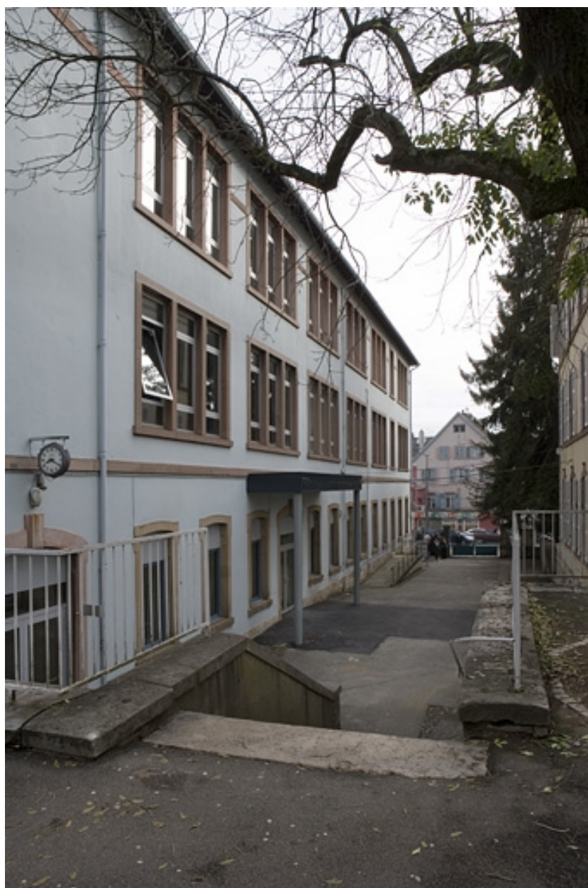
Bâtiment B. Vue face latérale droite.
