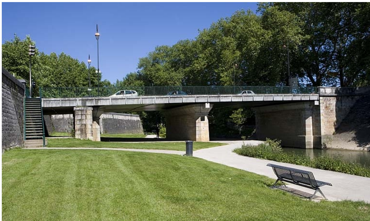
L'arche marinière du pont de la République.
