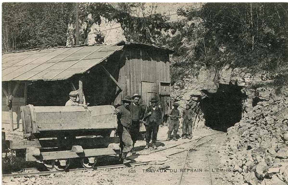
605. Travaux du Refrain - L'entrée du tunnel, vers 1908.
