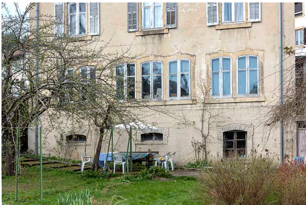
Façade postérieure : fenêtres horlogères et fenêtres multiples.
