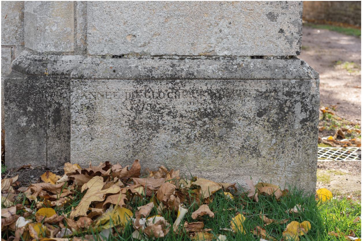
Base du pilier de la grille d'entrée.
