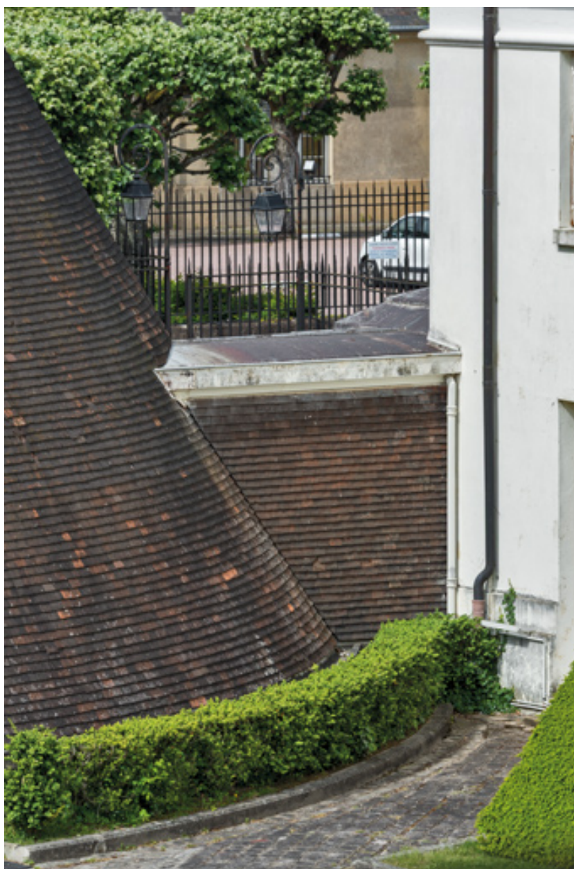
Corps de jonction avec l'aile de la Marine : élévation postérieure.
