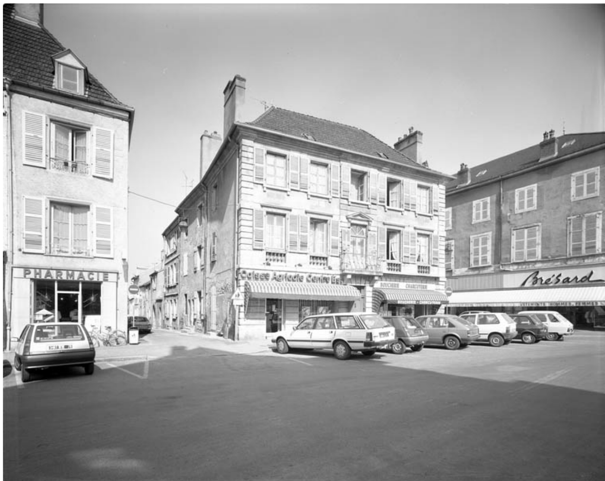
Façade antérieure et latérale gauche.
