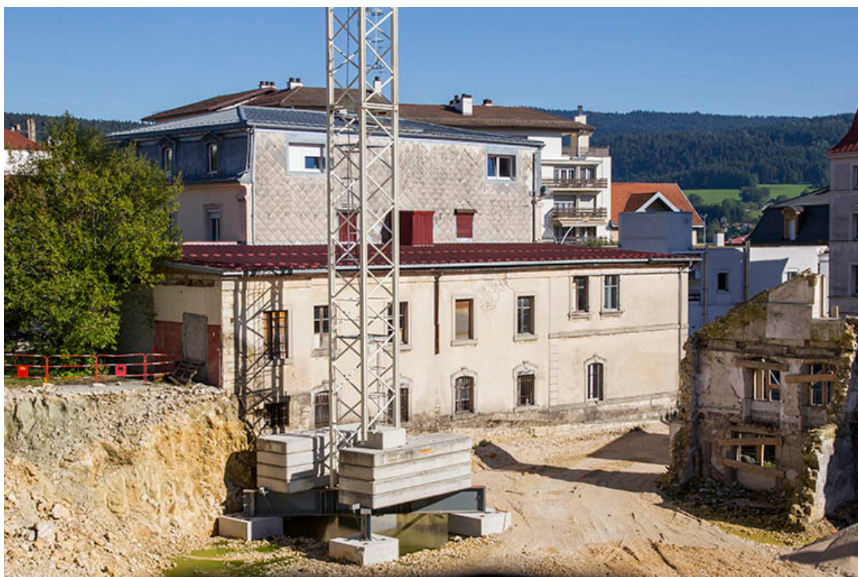
Façades latérale gauche et postérieure.
