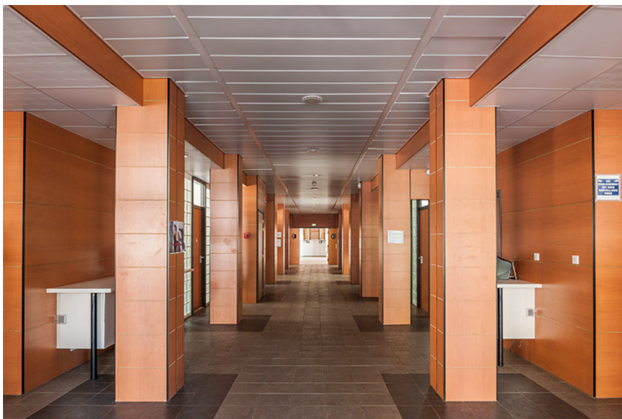
Internat : couloir du rez-de -chaussée restructuré.
