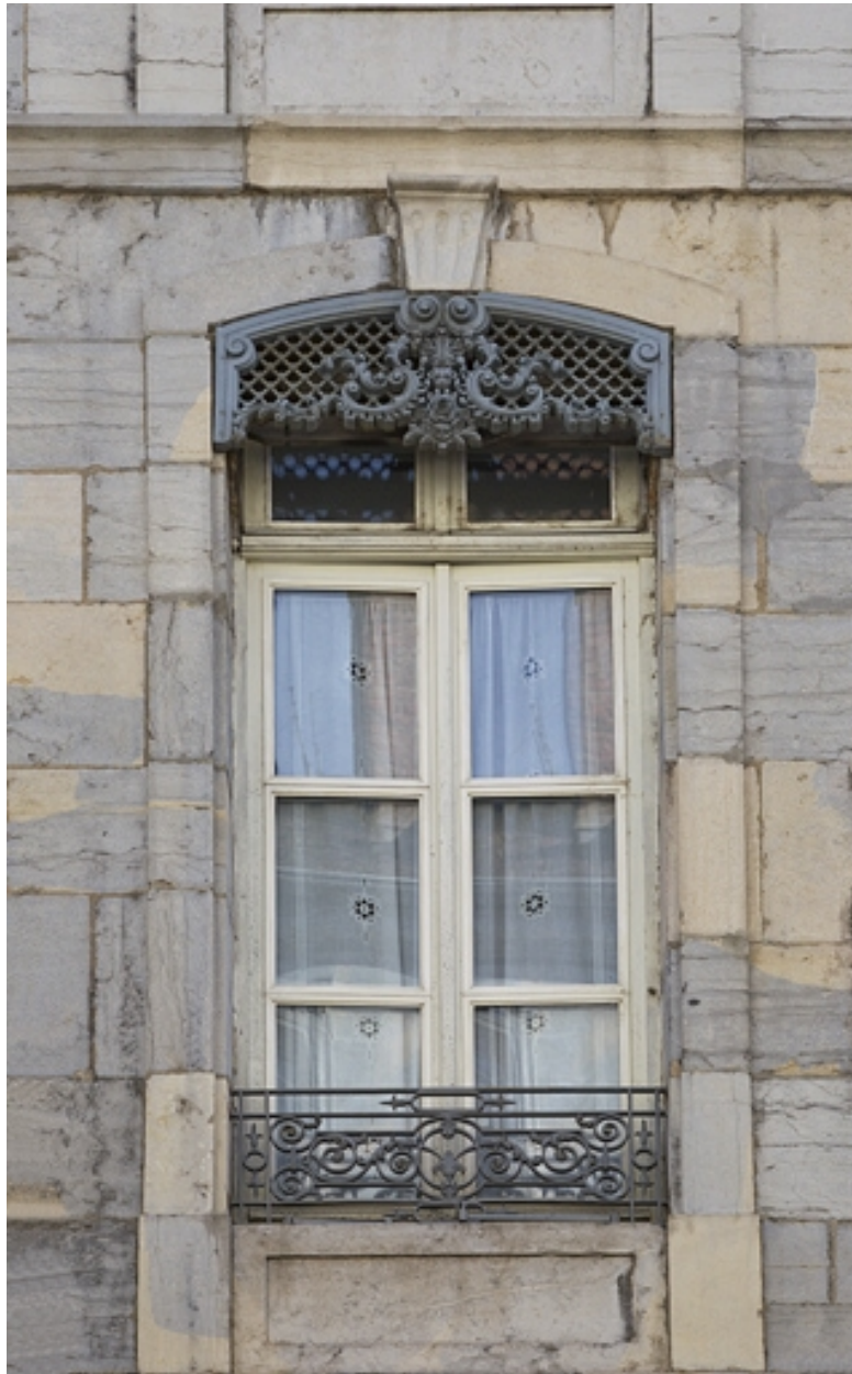
Logis principal, façade antérieure : détail d'une fenêtre du premier étage.
