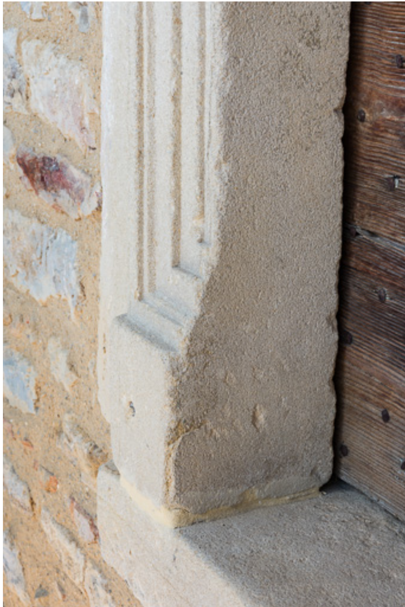
Détail d'une baie moulurée du XVI e siècle, à l'étage de la maison
