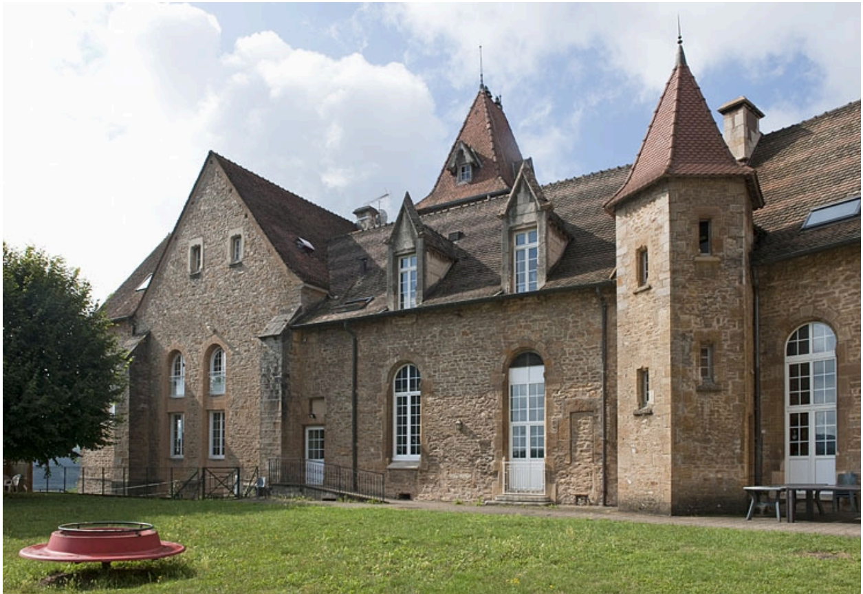
Bâtiment (C), côté jardin.
