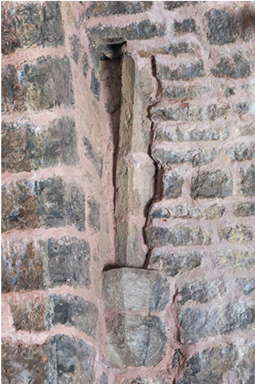
Mur ouest du puits d'Aval. Retombée d'une ogive et culot.
