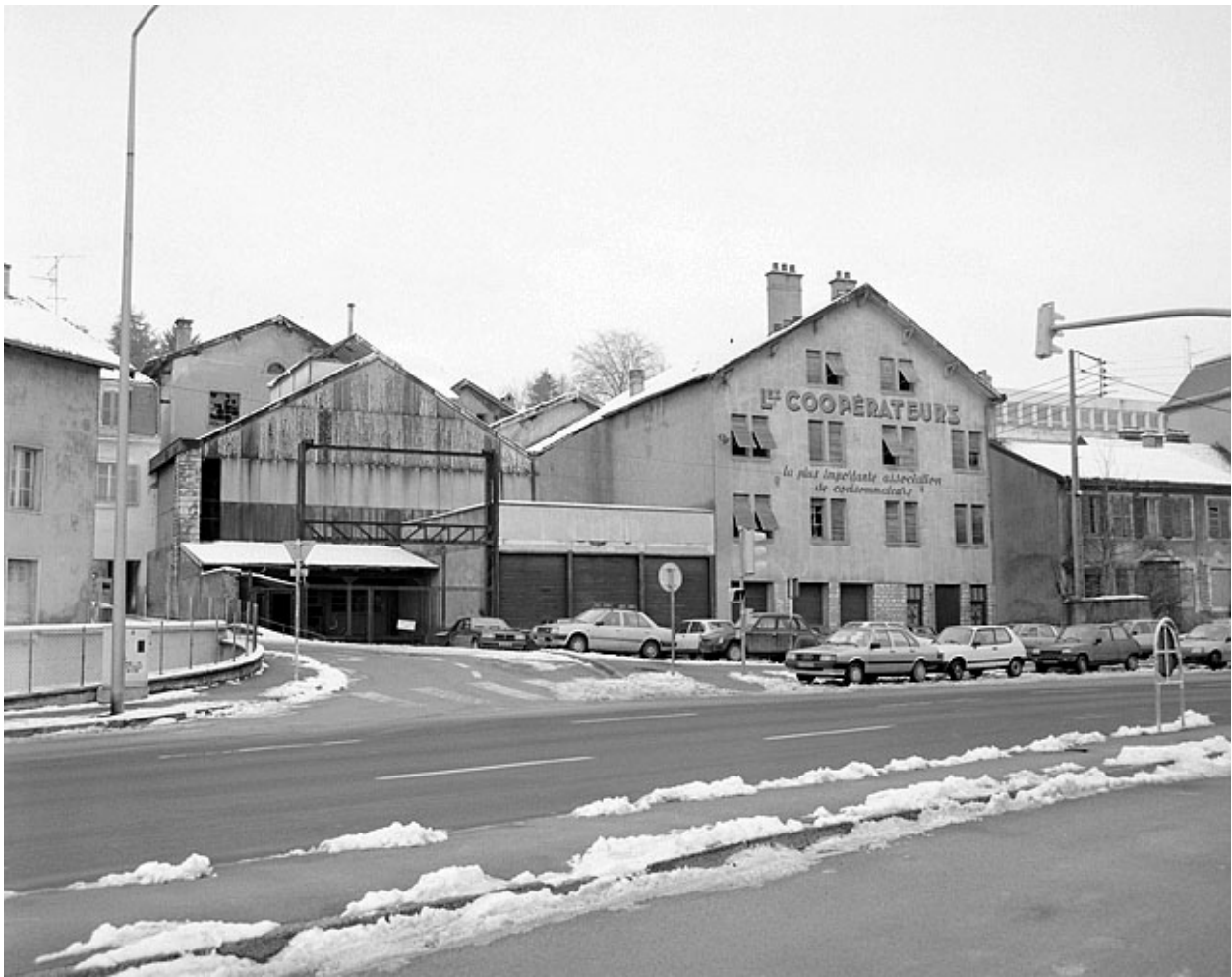
Vue d'ensemble sur la rue des Huisselets.
