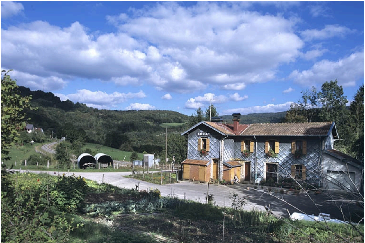
Vue d'ensemble, depuis l'ouest.
