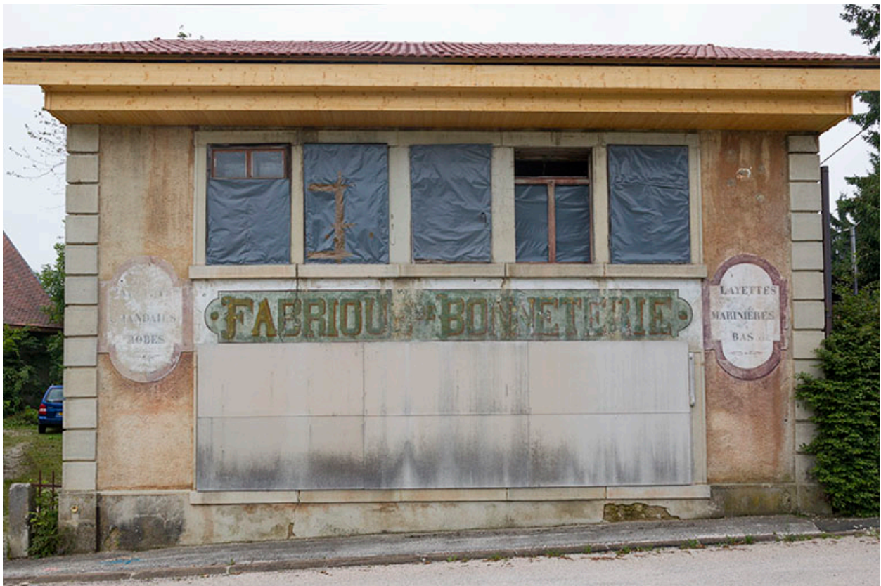
Usine : façade antérieure.
