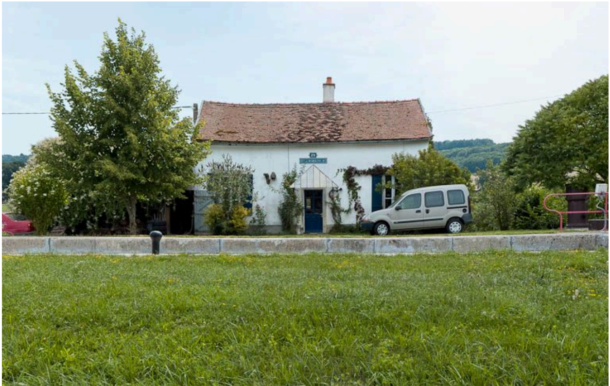
Vue de face de la maison éclusière.
