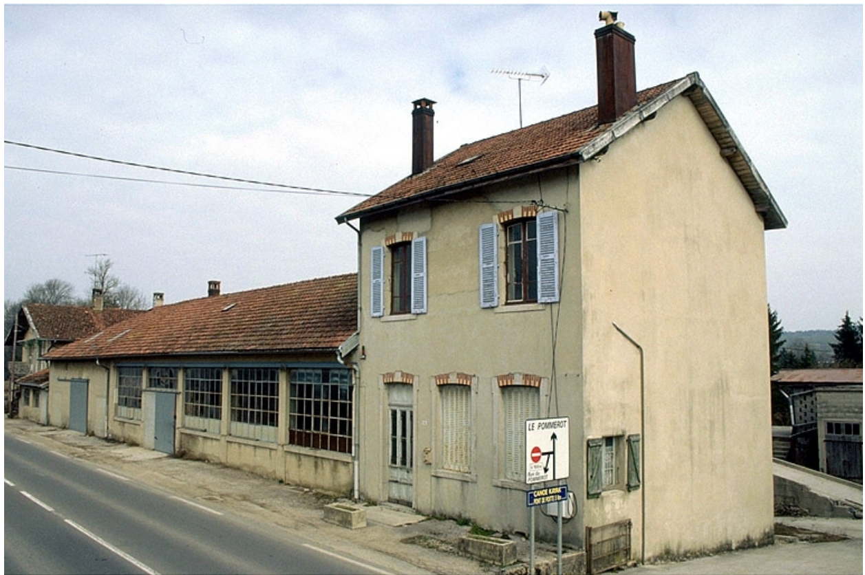
Atelier de fabrication (tabletterie) et logement.
