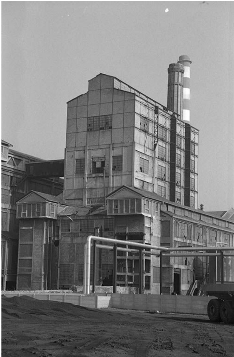
La chaufferie de Lucy II construite en 1919-1920 et son extension, pignons sud.
