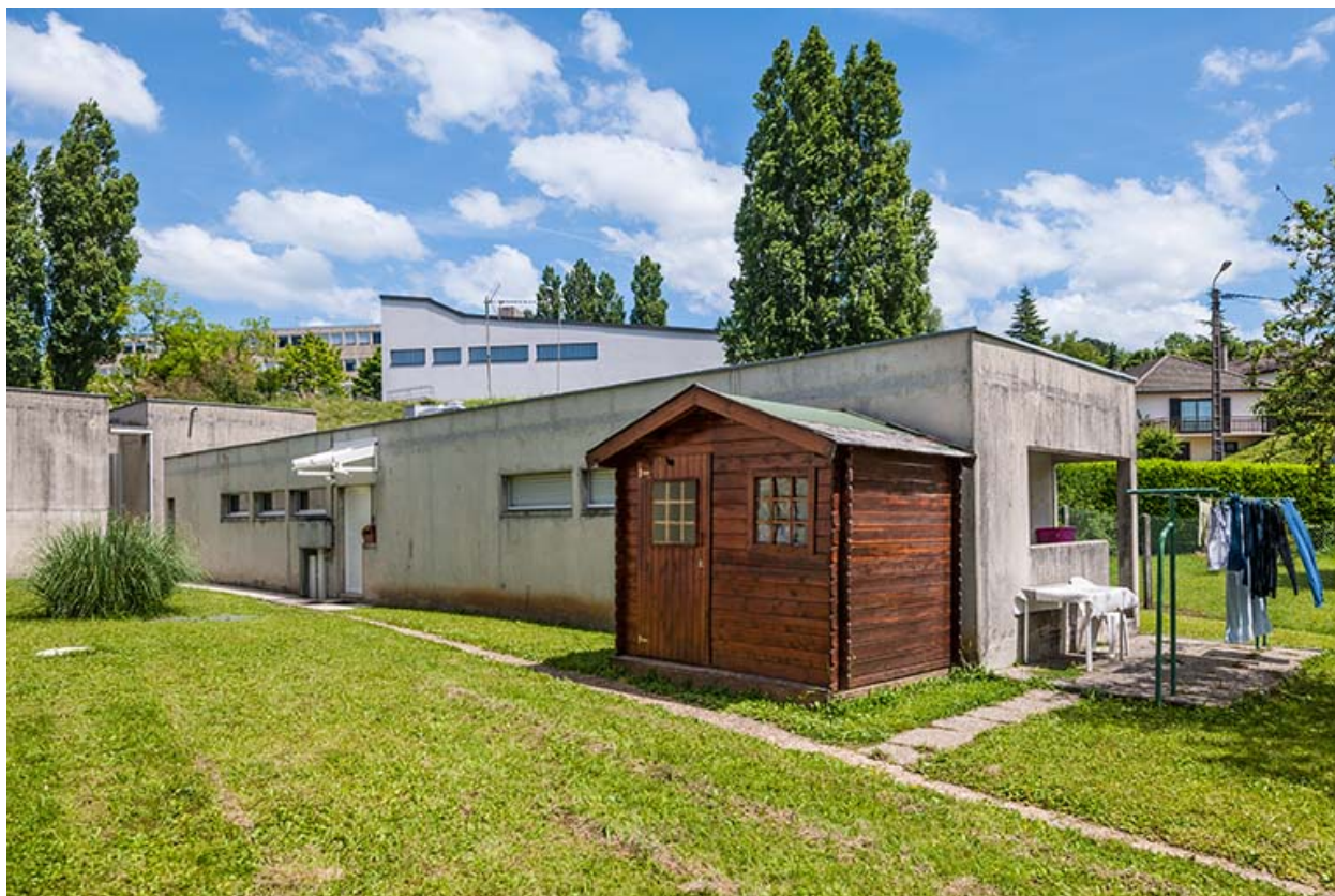
Logements : façades postérieures
