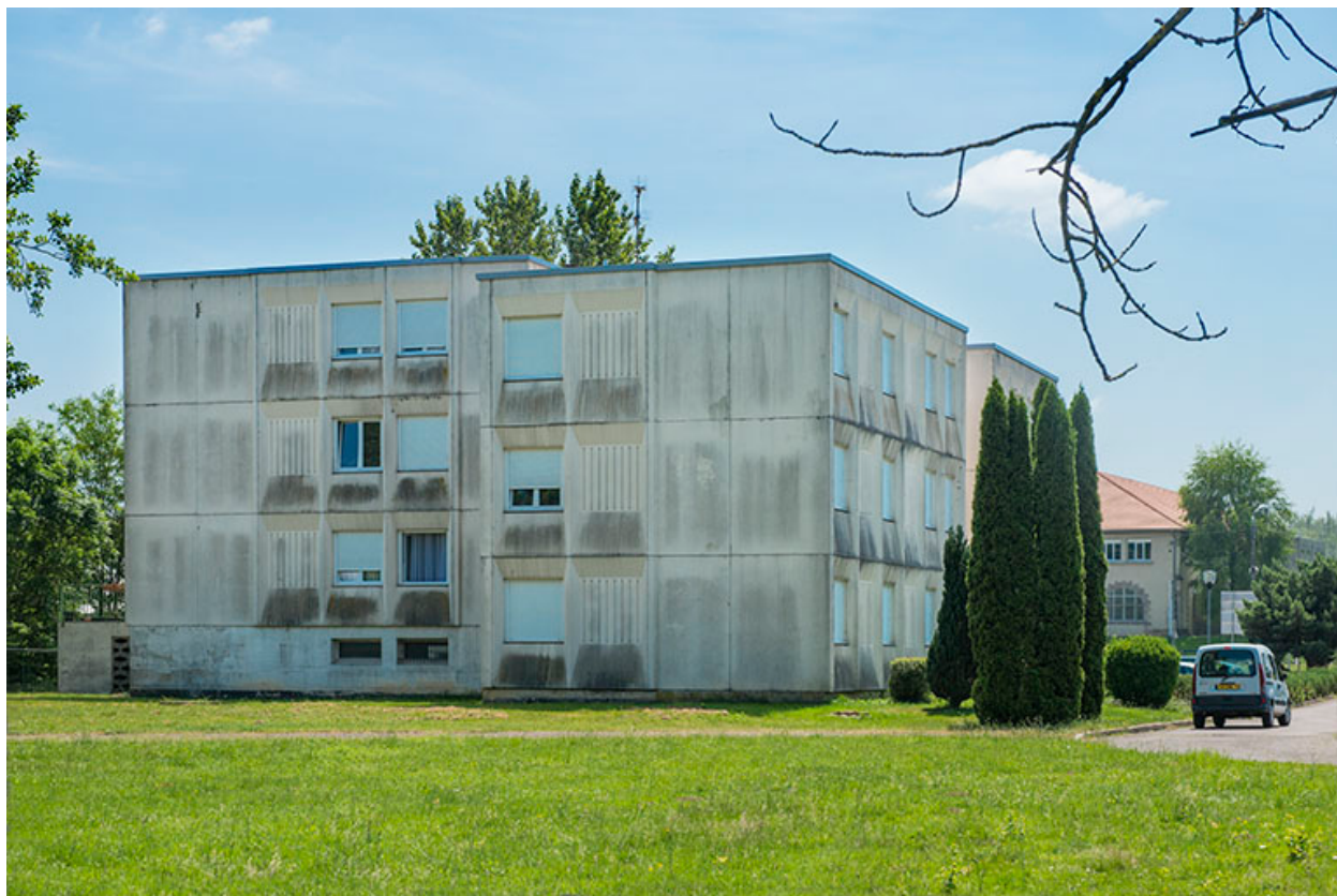
Angle nord-ouest des logements de fonction.
