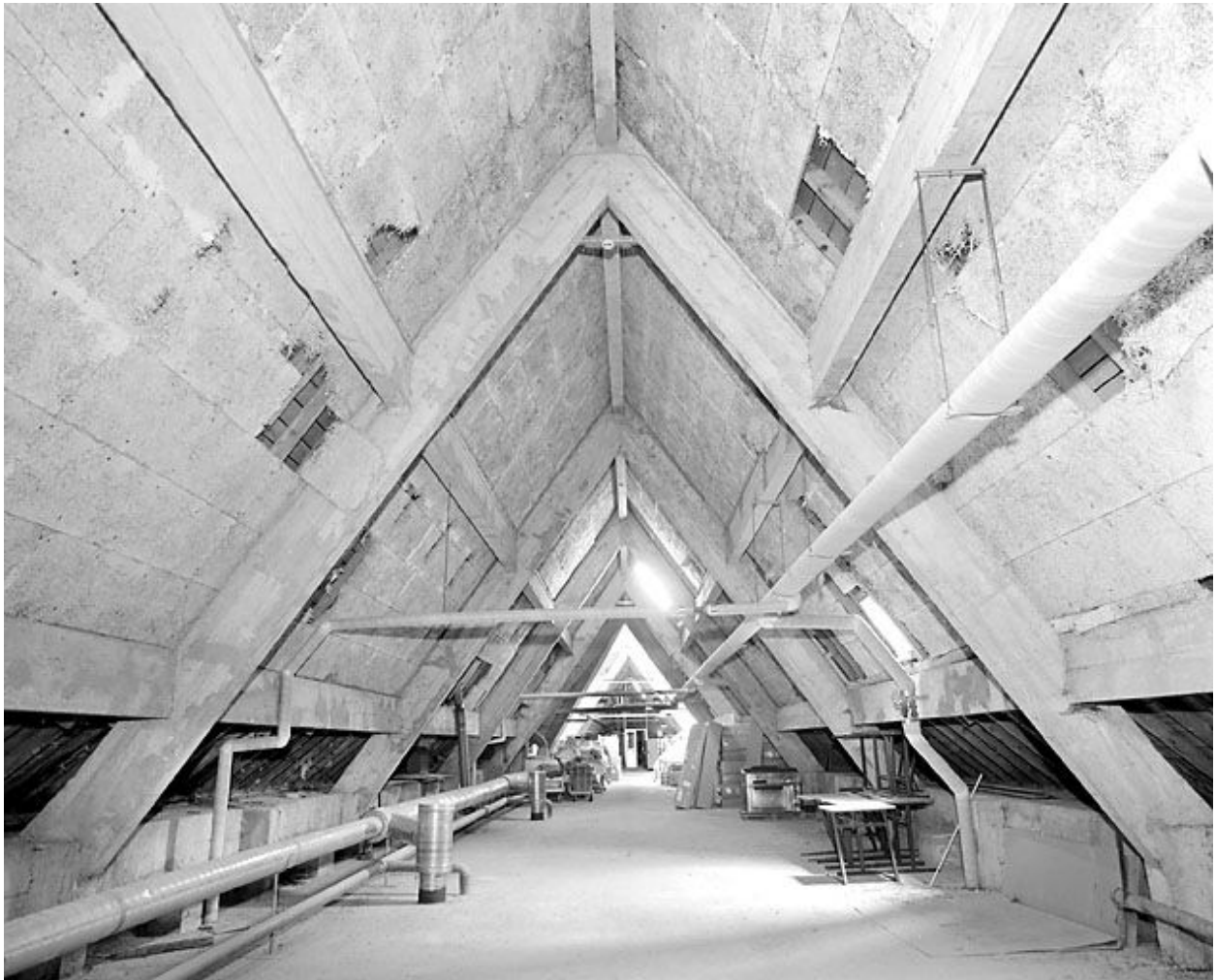
Bâtiment B : charpente en béton.
