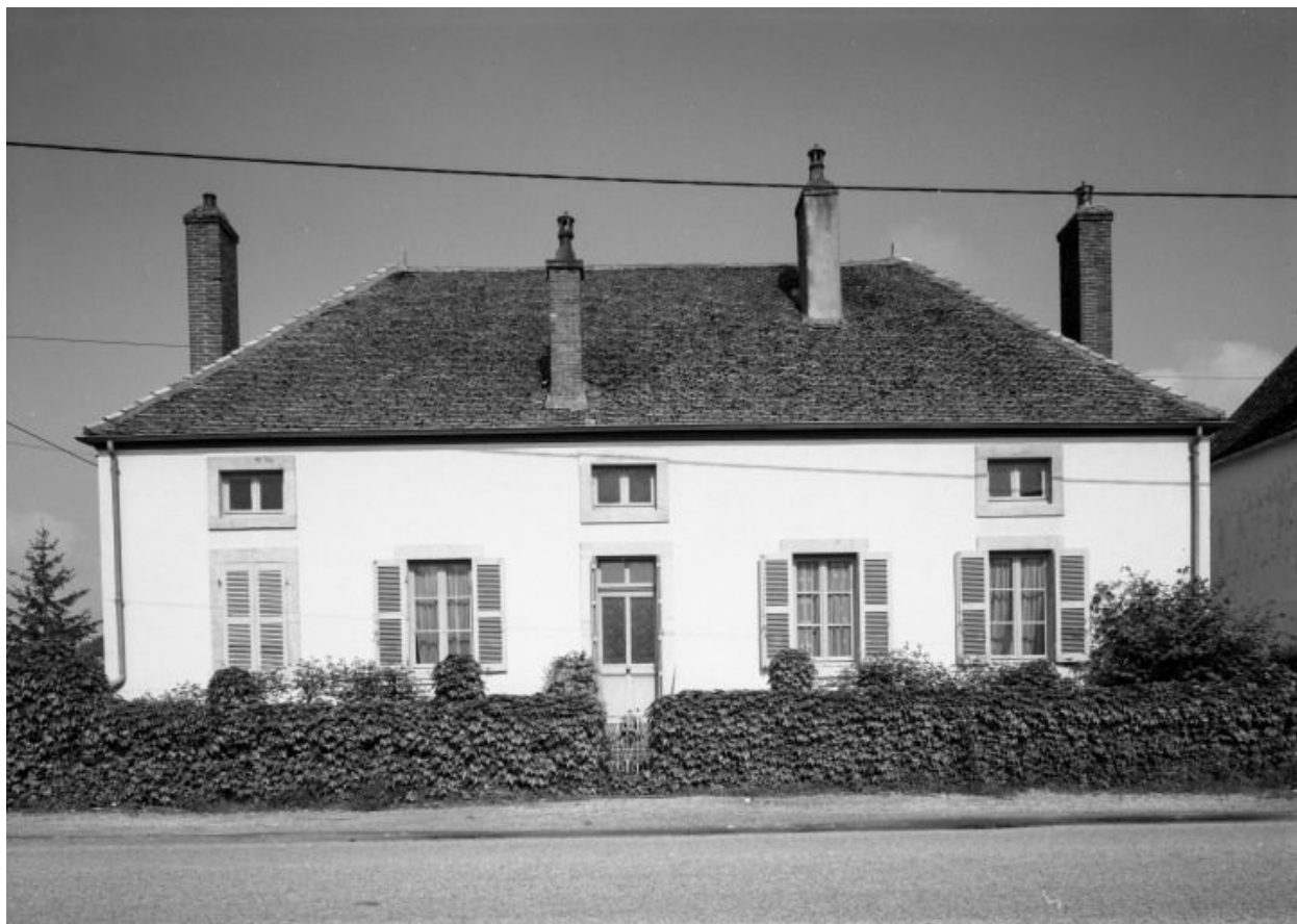
Vue d'ensemble d'une maison (cad. 1981, sect. B2, parc. 435).
