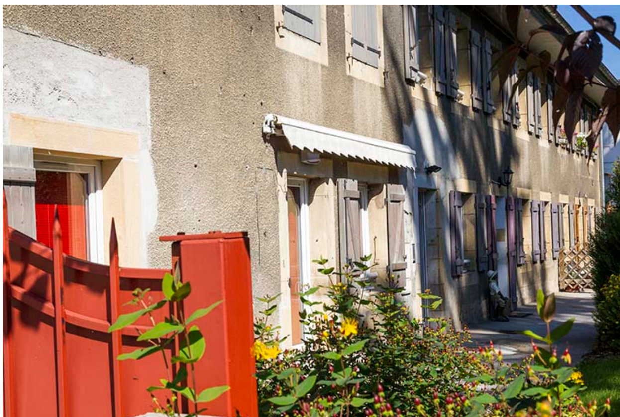
Façade latérale droite.
