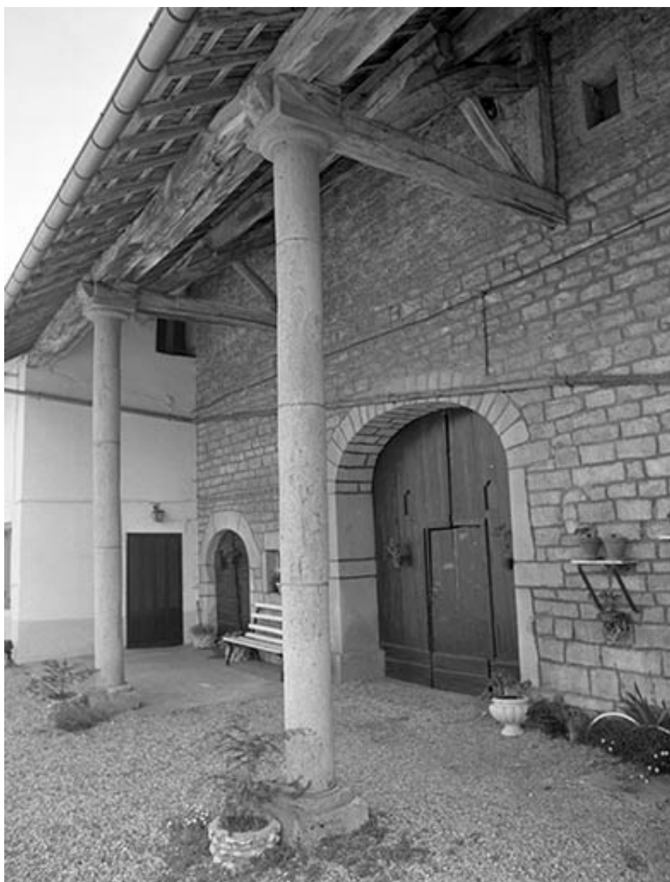
Façade antérieure : détail de l'avant-toit.
