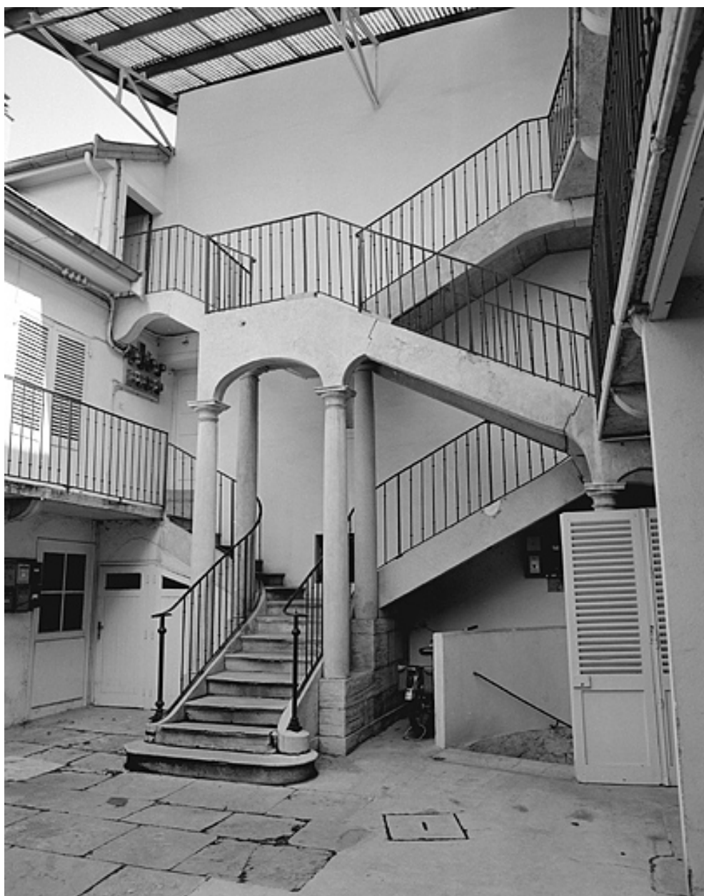
Maison, 74 rue Saint-Désiré, escalier sur cour.
