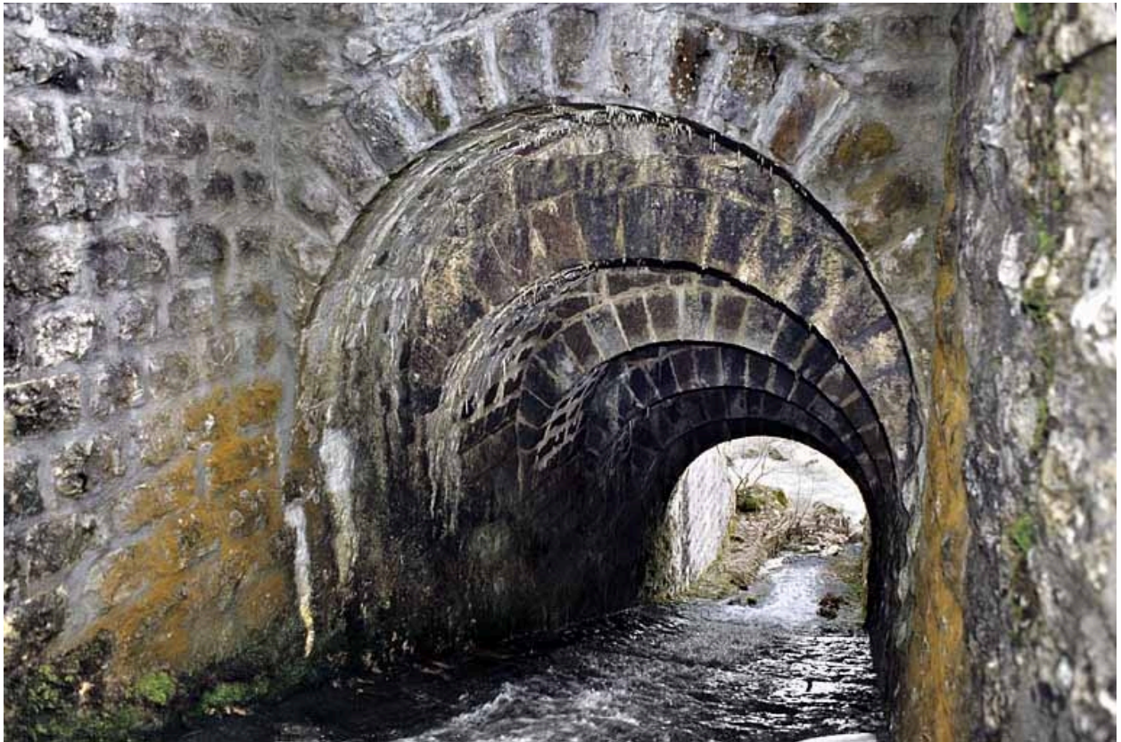
Pont : voûte appareillée en rouleaux à ressauts, depuis le nord (amont).
