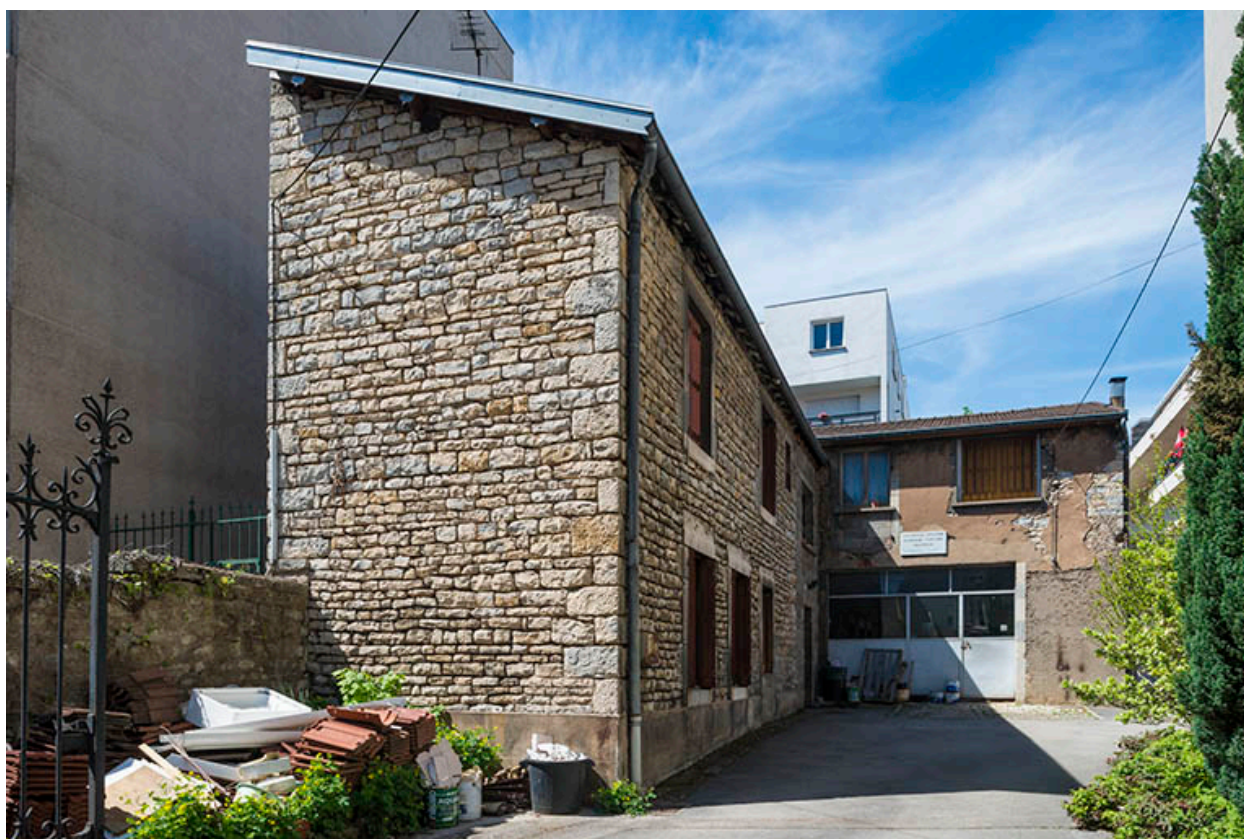
Les ateliers sur cour.
