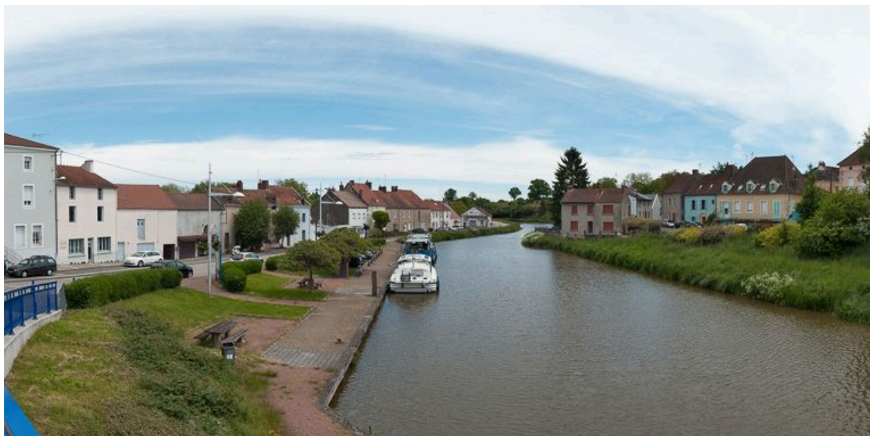
Vue d'ensemble du port de Blanzay depuis le pont routier.
