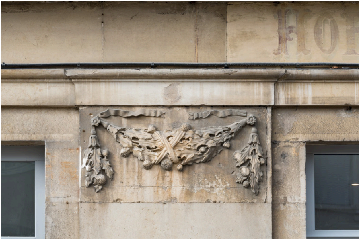
Façade antérieure, 6e pilastre (en partant de la gauche) : guirlande sculptée.
