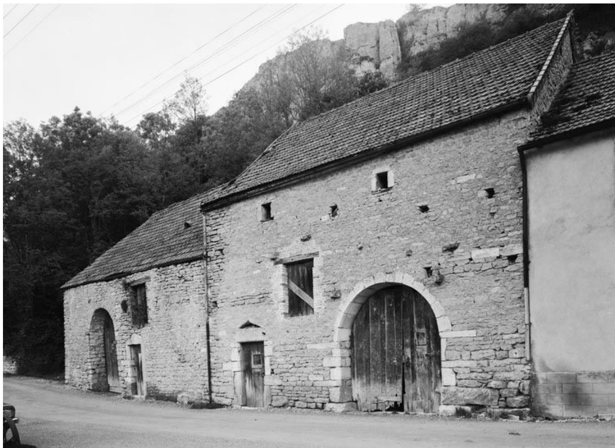
Vue d'ensemble des cuveries (parcelle 71, section B1 du cadastre de 1953).
