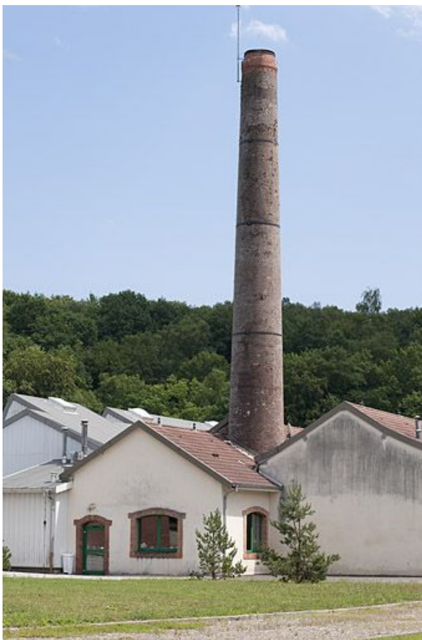
Cheminée et pignons nord des ateliers.
