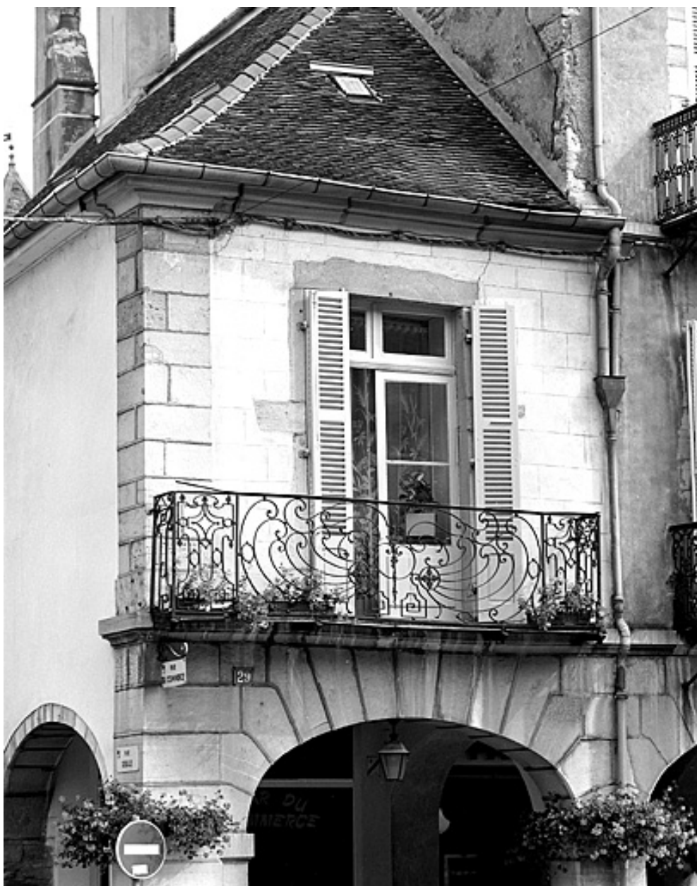
Façade antérieure, balcon.
