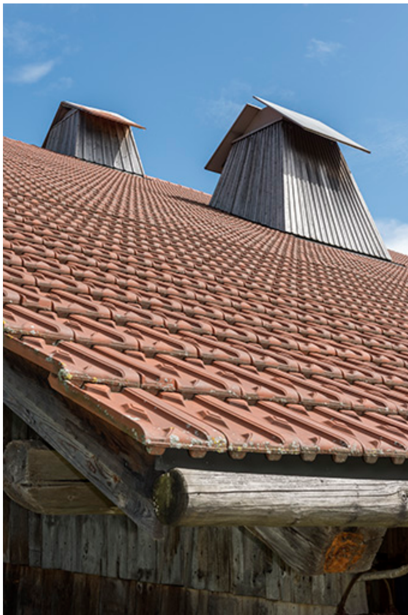
Pan de toiture sud, avec deux "tués".
