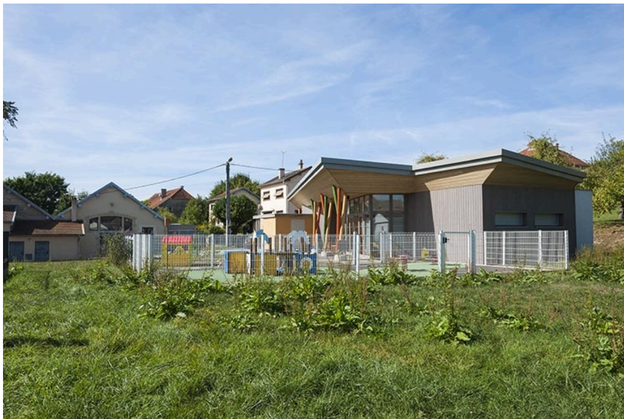
Vue d'ensemble de la crèche.
