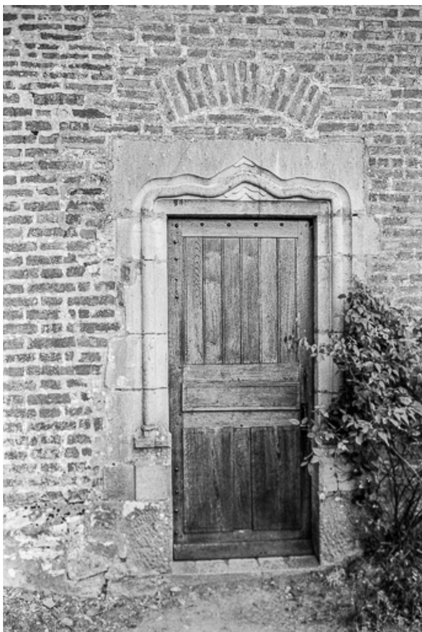
Extérieur : porte latérale.
