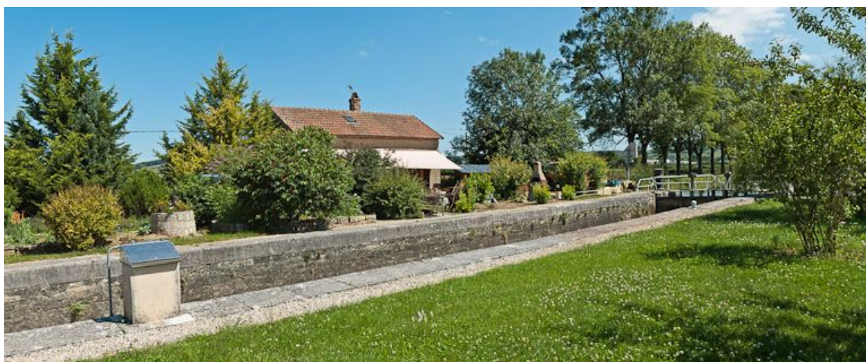
Vue d'ensemble du site d'écluse.
