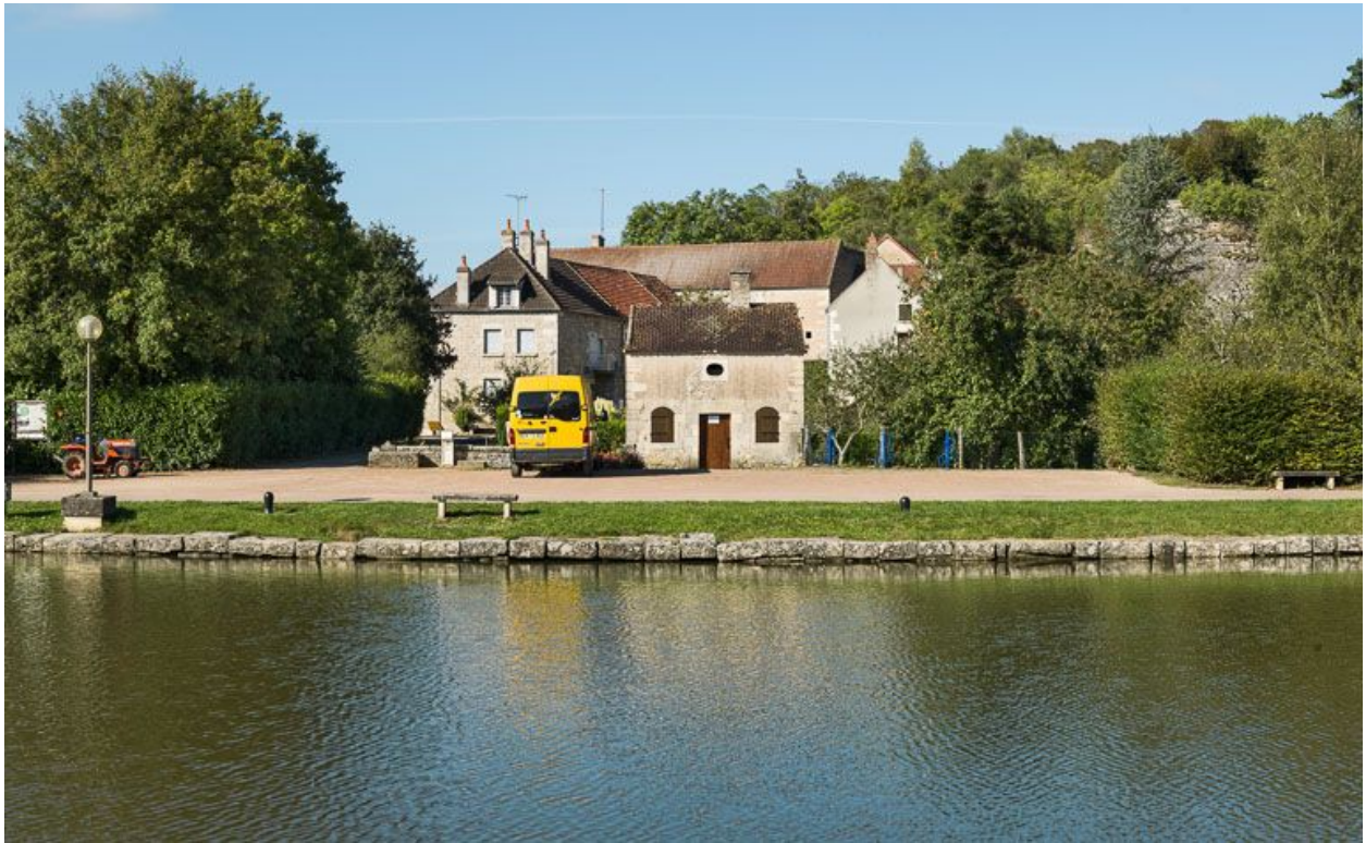
L'abri des ouvriers : vue de face.
