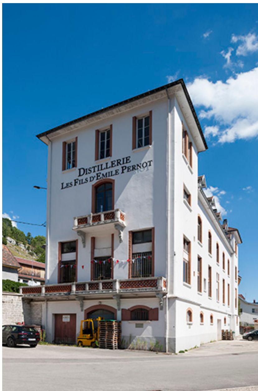
Pignon ouest et façade postérieure.
