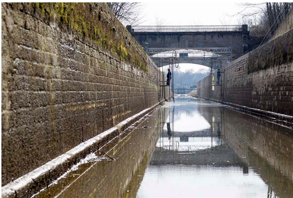
Travaux de restauration de maçonnerie en 2015.
