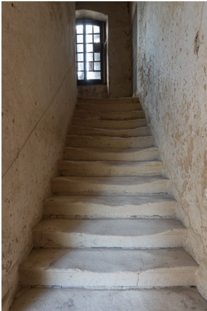
Une des volées de l'escalier rampe sur rampe de la demeure
