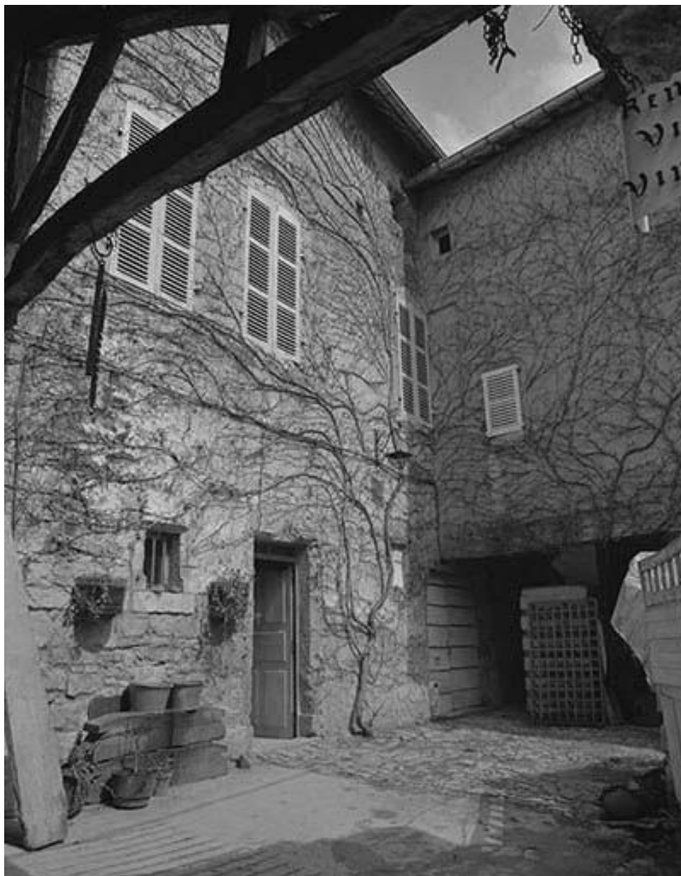
Façade sur la cour.
