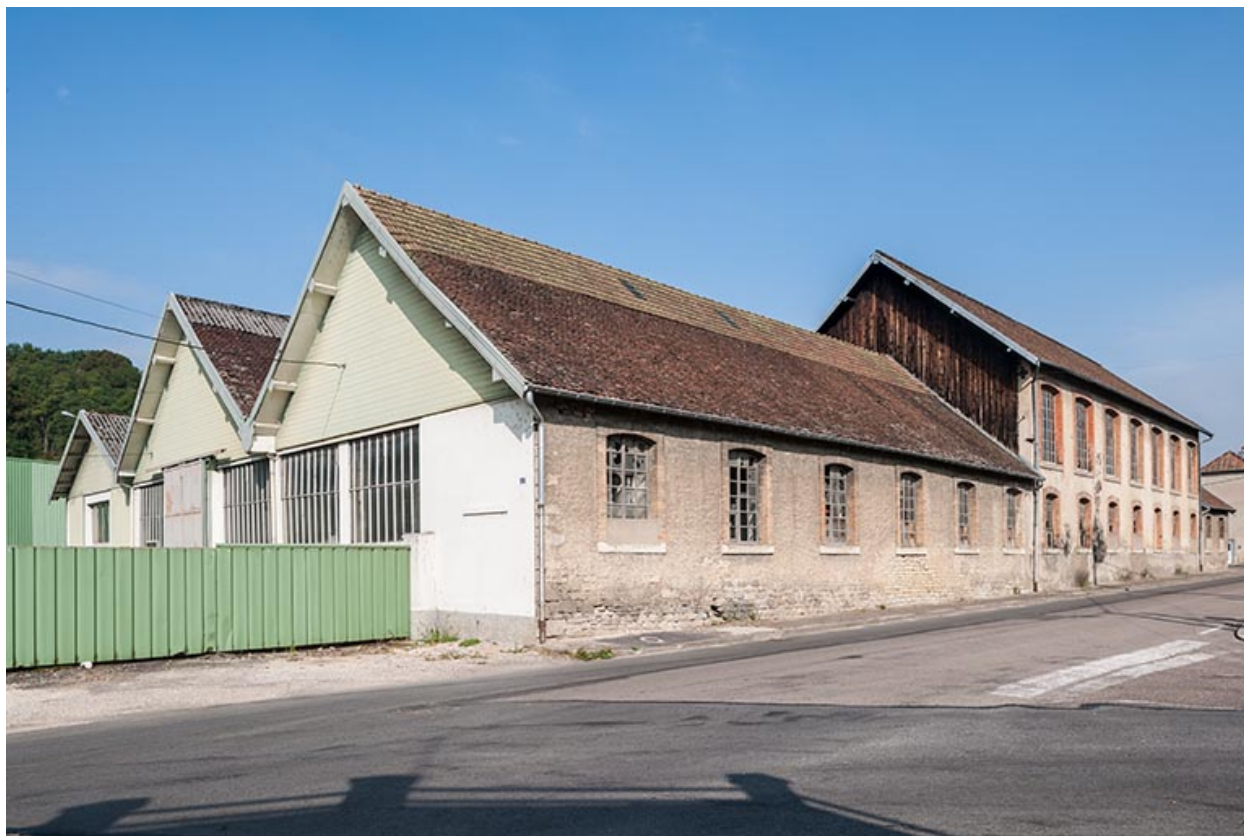
Atelier de fabrication depuis le sud-est.
