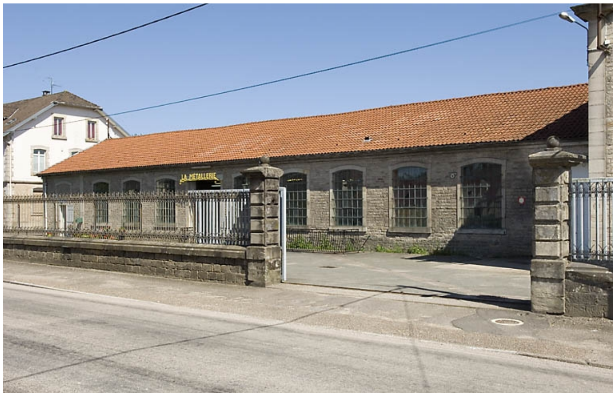
Cour et bâtiment nord en rez-de-chaussée.
