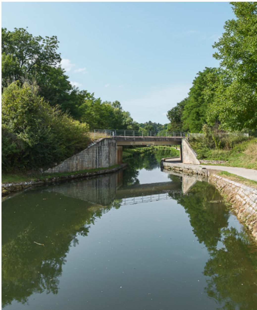
Vue d'ensemble du pont.
