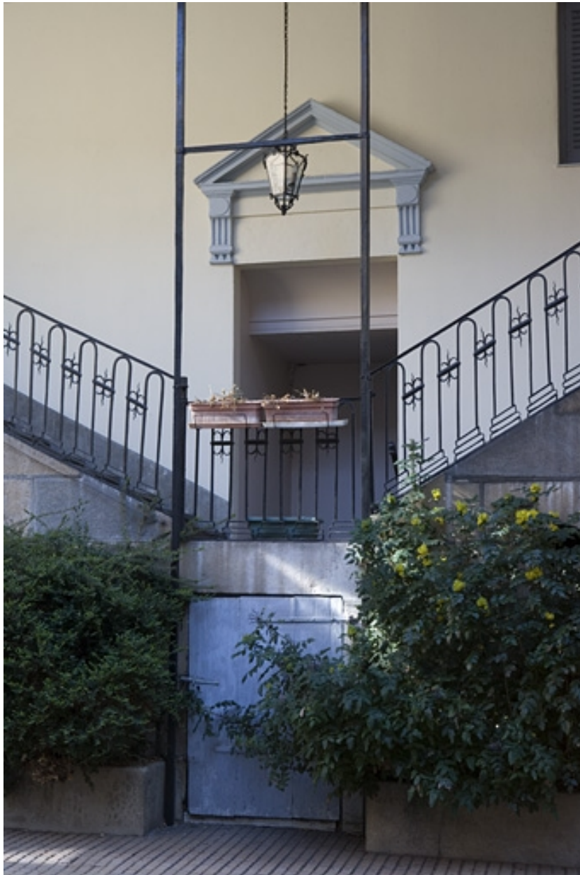
Détail du premier palier de l'escalier à cage ouverte.
