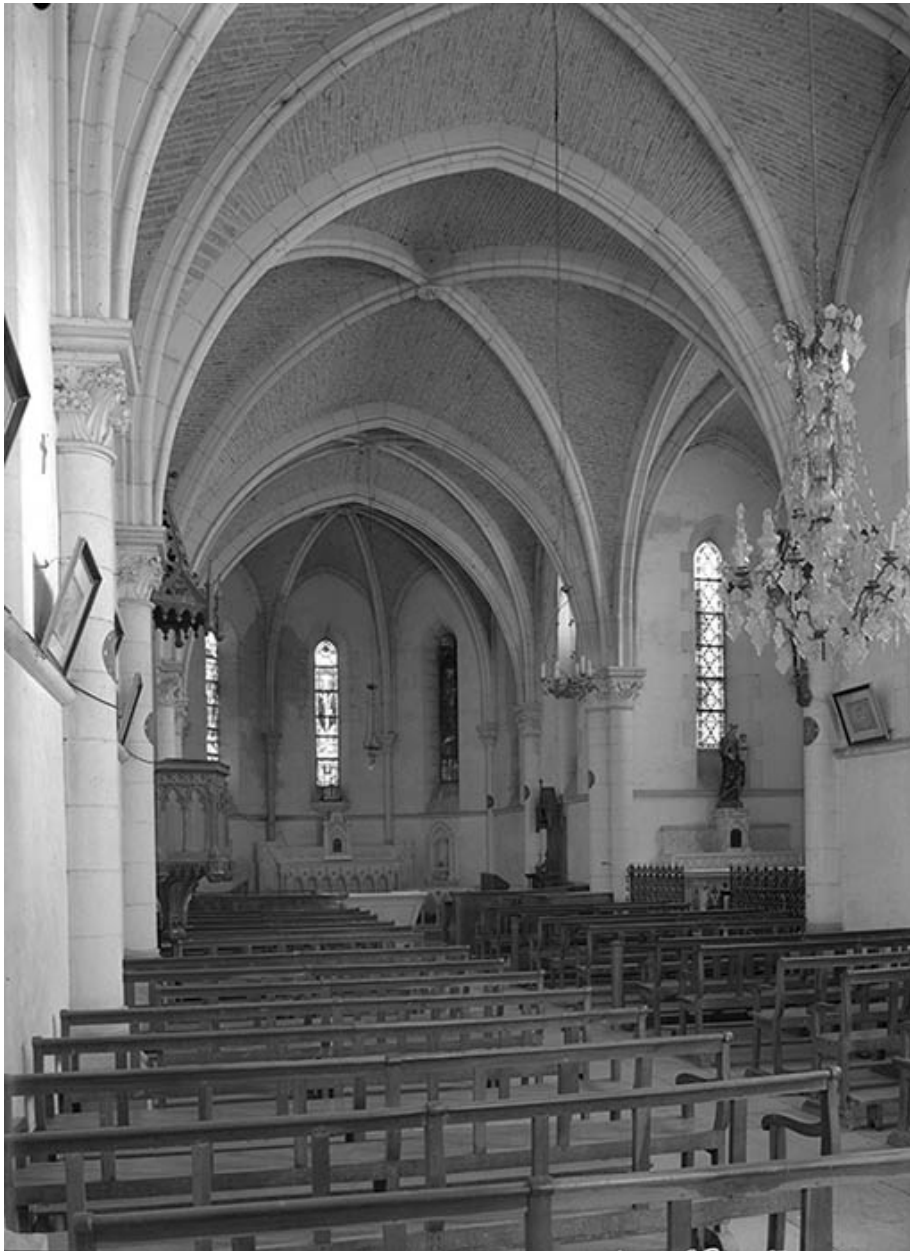
Vue intérieure vers le chœur. Voûte d'ogives.
