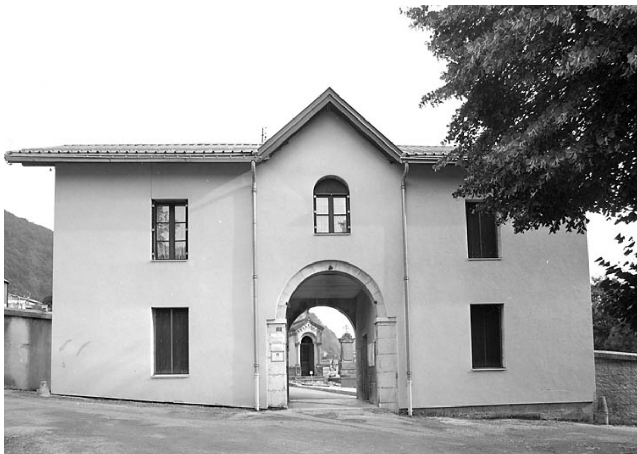
Pavillon d'entrée (conciergerie et logement).
