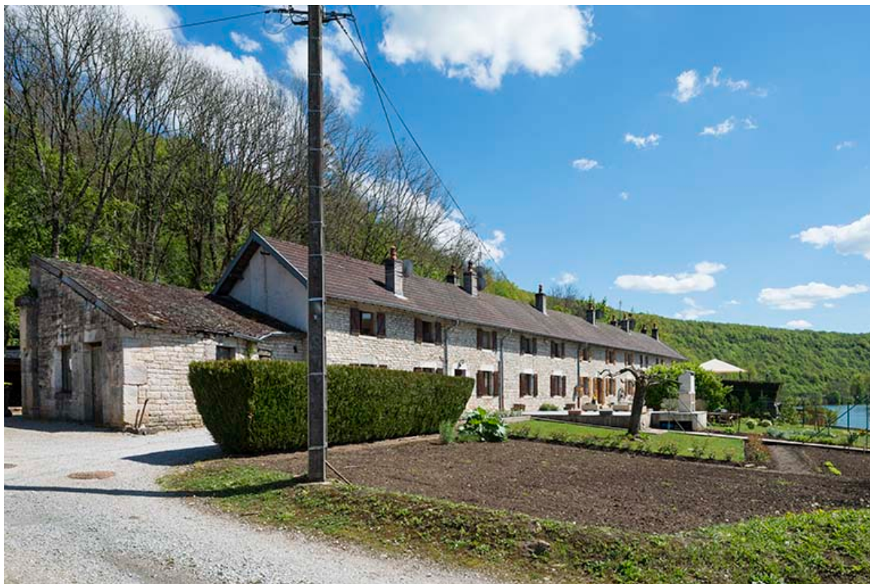
Logement ouvrier sud. Vue de trois quarts.
