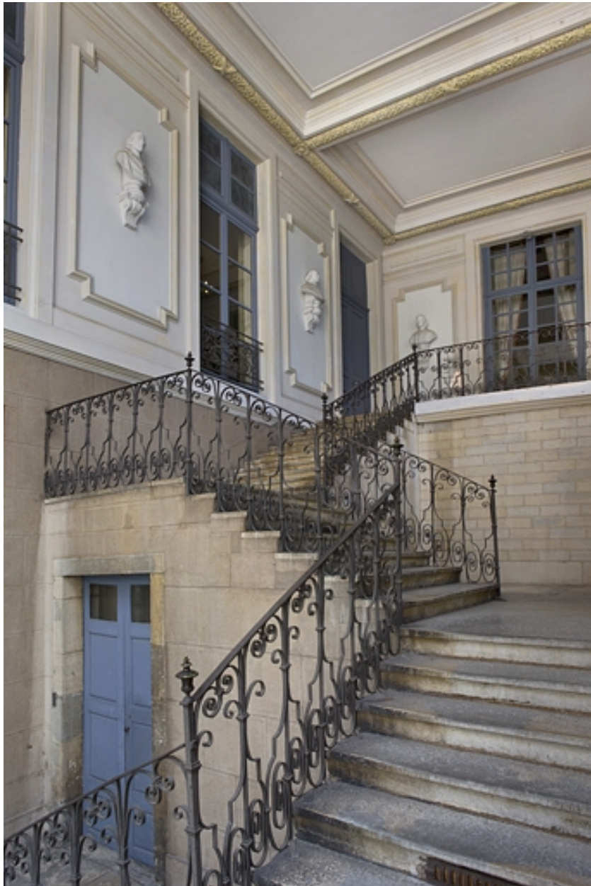
Vue d'ensemble de l'escalier, de trois quarts droit.
